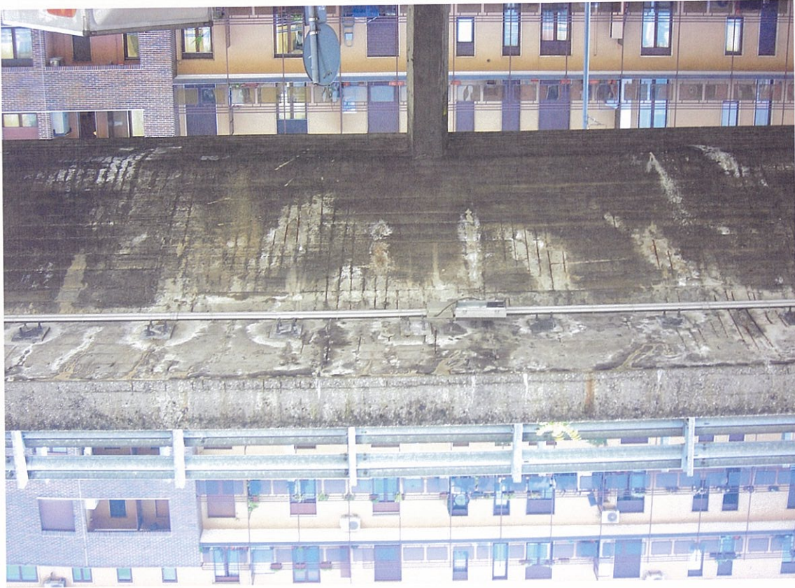
FOTO 25 - Dettaglio del degrado del cassone sulla pila 8 (esterno curva)
